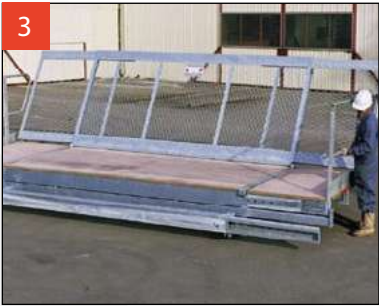
Mise en place des fermetures
