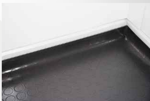
Revêtement de sol antidérapant (remonté sur les bords)
