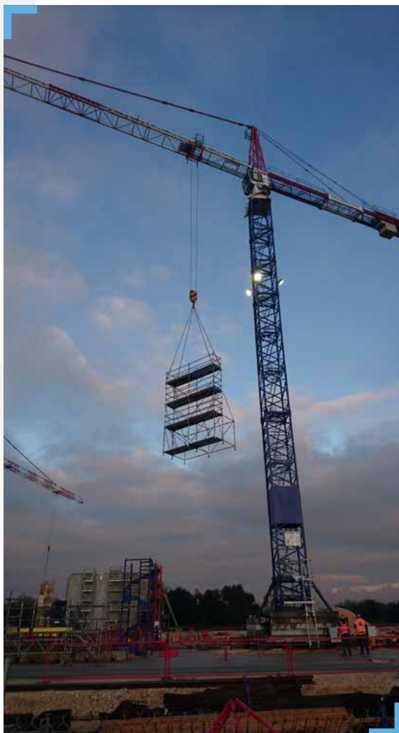
Exemple échafaudage de ferrailage avec arrière-structure
